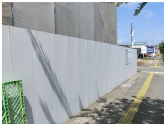
仮囲いの設置
