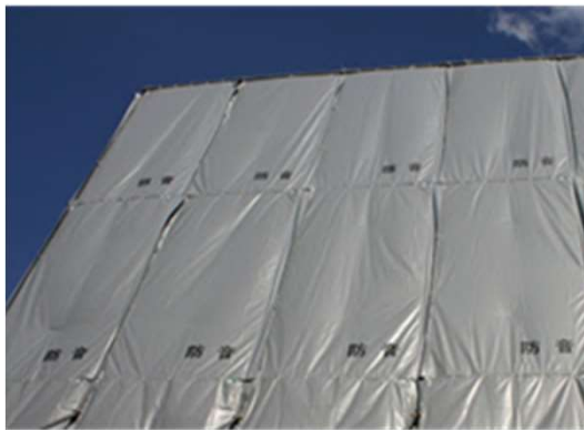
防音シート（騒音・粉塵対策）
